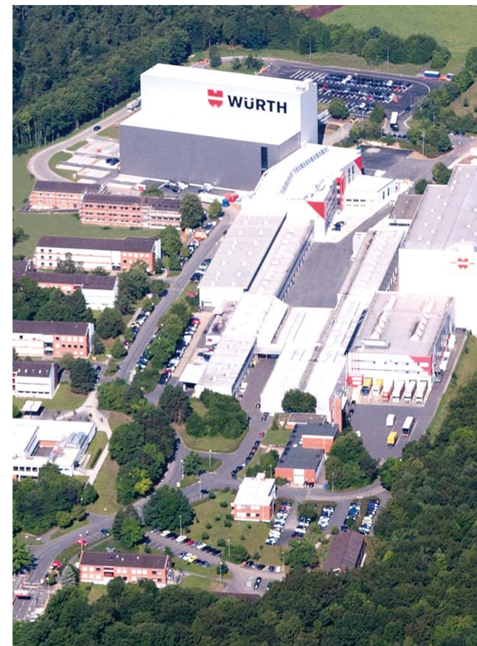
Zentrallager der Würth Industrie Service GmbH & Co. KG: Industriepark Würth am Standort Bad Mergentheim
