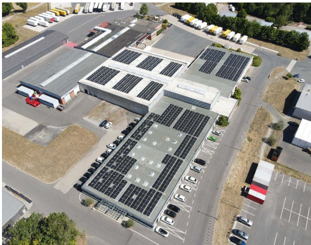
Bild 2: Photovoltaik.jpg Bildunterschrift 2: Zur nachhaltigen Energiegewinnung setzt die Würth Industrie Service auf den Einsatz hocheffizienter Photovoltaikanlagen. Bildquelle 2: Paul Dürr, Würth Industrie Service GmbH & Co. KG
